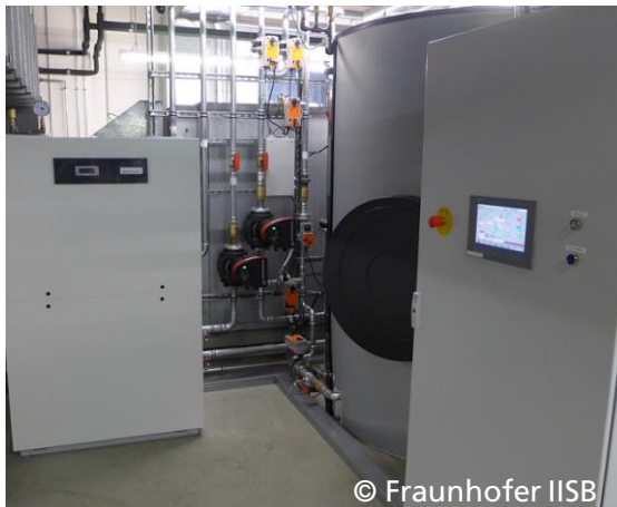
Wärmepumpensystem für Wärmerückgewinnung aus Abluft
