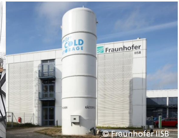
Großer Kältespeicher für Flexibilisierung der Kältesystems
