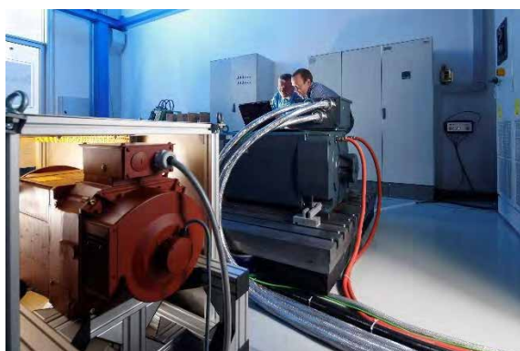
Abbildung 114: Antriebsprüfstände bis eine Leistung von 400 kW
