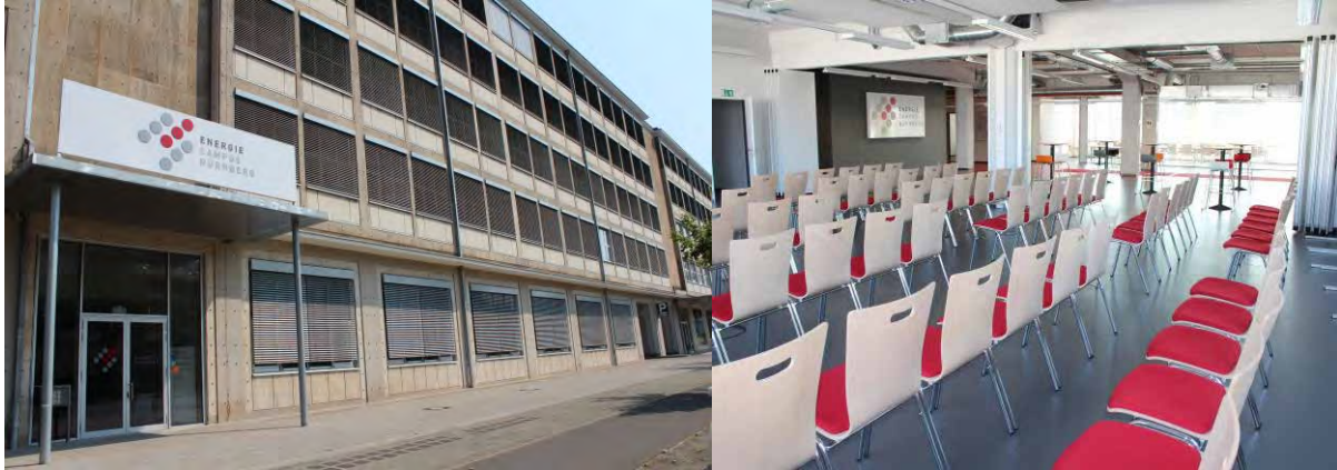
Abbildung 8: Das EnCN Hauptgebäude bietet auf 5 Etagen mit 5000qm Fläche Raum für 150 Forscher und für Veranstaltungen mit bis zu 170 Besuchern.
