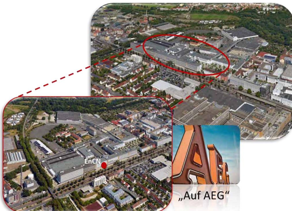
Abbildung 7: Der EnCN befindet sich in der Nürnberger Weststadt, auf dem ehemaligen AEG Gelände, direkt an der Fürther Straße.
