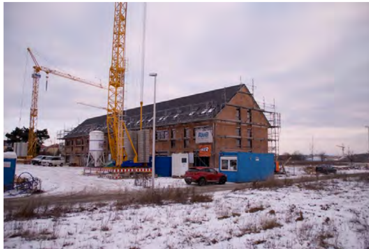
Abbildung 136: Baufortschritt Herzo Base Energiespeicherhäuser am 18.01.2017
