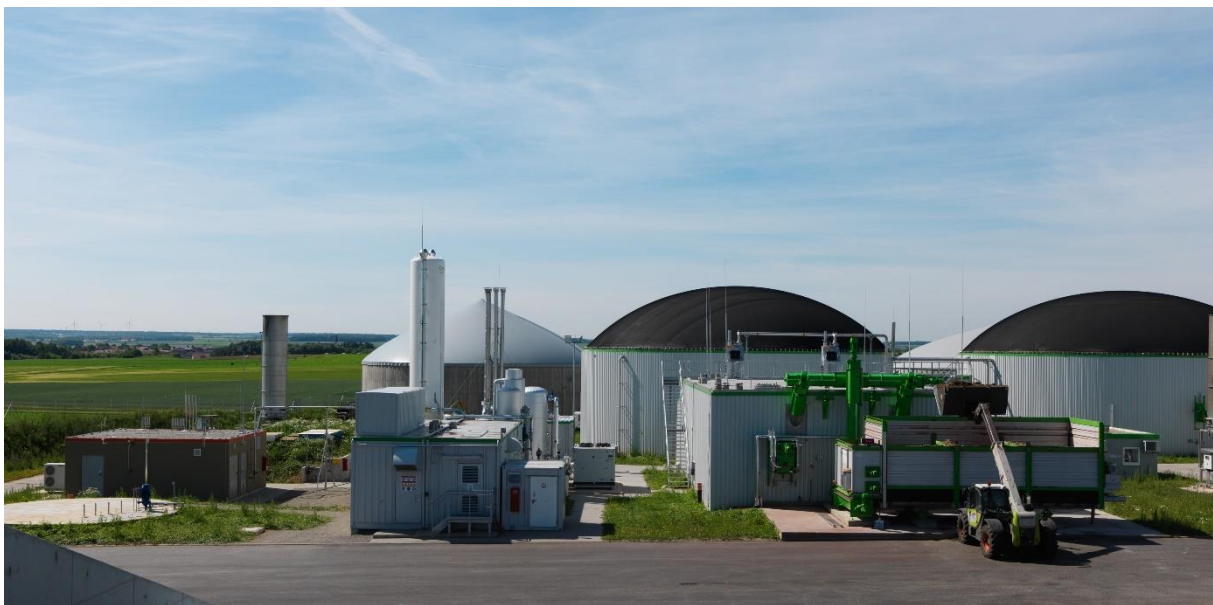
Abb. 15: N-ERGIE Biomethananlage Gollhofen (Bild: N- ERGIE 25 )
