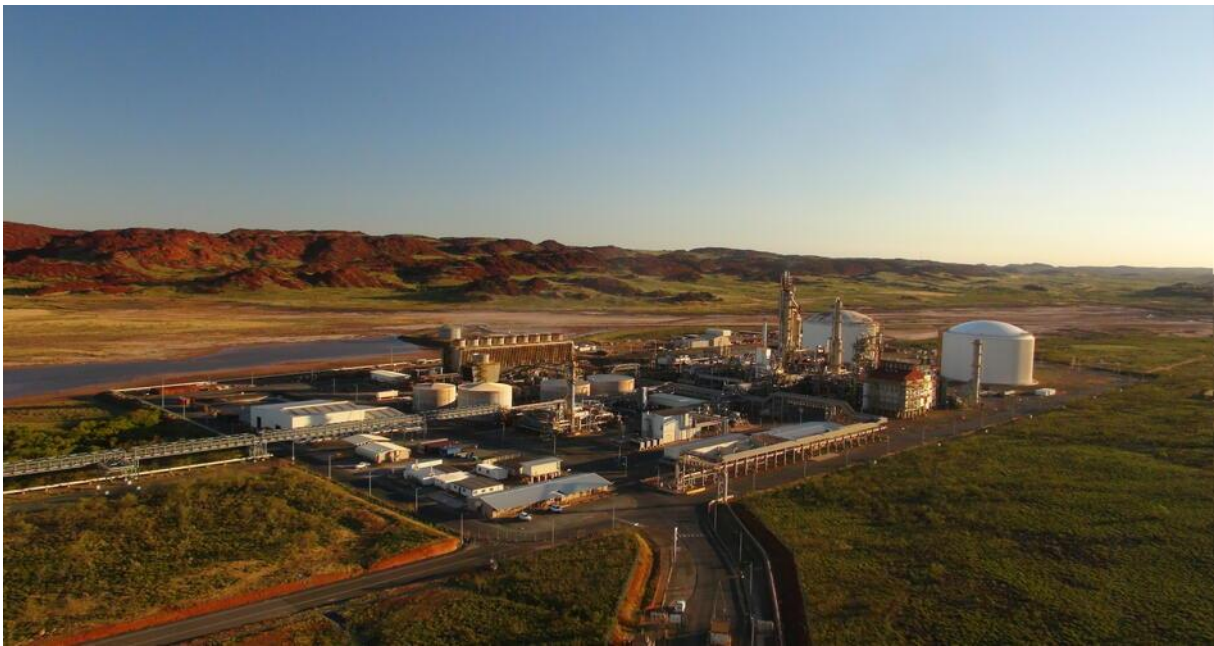
Abb. 53: Yaras „renewable hydrogen to ammonia“-Anlage für die Produktion CO 2 -neutraler, „grüner“ Düngemittel, Pilbara, West-Australien (Foto: Yara)
