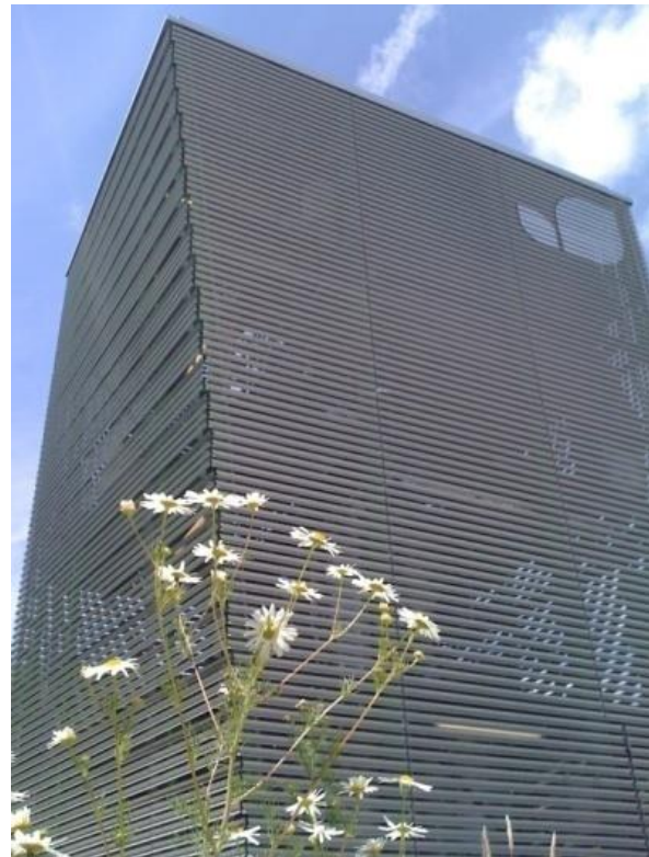
Abb. 21: 500 kW Wasserdampfvergasungsanlage („Heatpipe Reformer“) für Biomasse der Fa. agnion Inc., Pfaffenhofen, 2010
