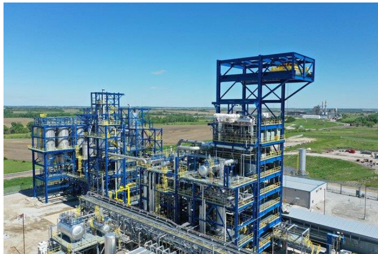
Abb. 32: Im Aufbau befindliche Methanpyrolyseanlage der Firma Monolith Materials in Olive Creek, Nebraska (USA) 48
