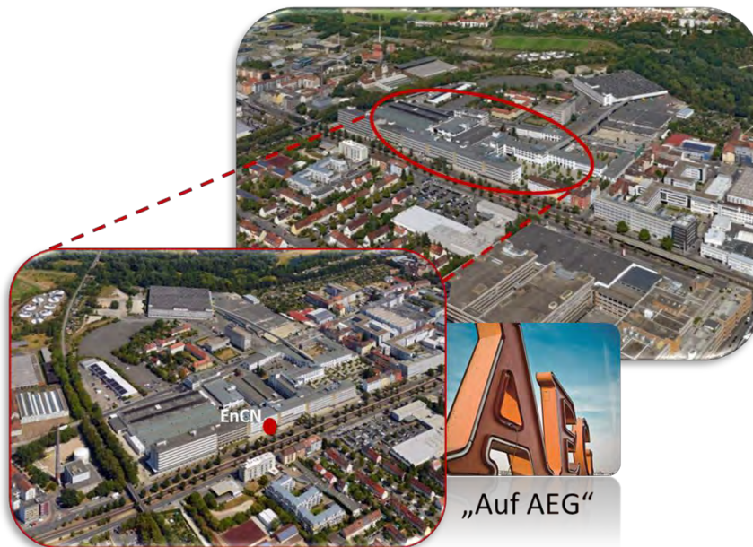
Abbildung 3 – Der EnCN befindet sich in der Nürnberger Weststadt, auf dem ehemaligen AEG Gelände, direkt an der Fürther Straße.
