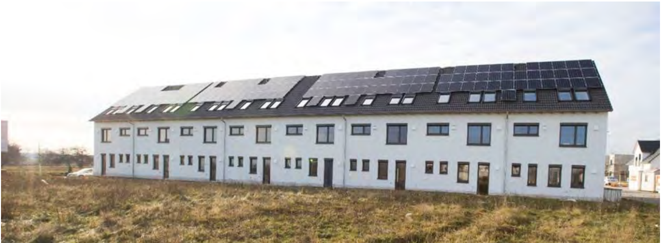
Abb. 16: Herzo Base - Energiespeicherhäuser: Ein Gebäudekomplex aus 8 hochgedämmten Reihenhäusern; von links nach rechts: Häuser 1 bis 8.
