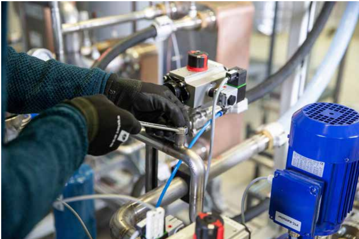
Abbildung 2: Montage der kombinierten Wärmepumpe-ORC Pilotanlage (Foto: EnCN/Zellner)
