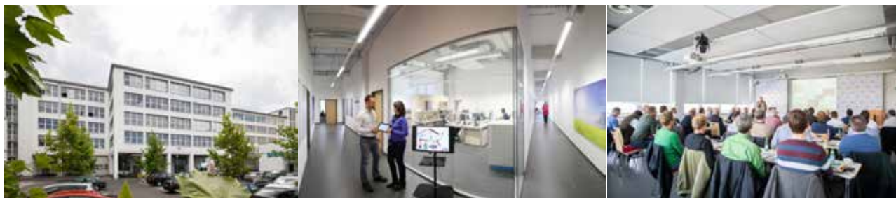
Abbildung 6: Das EnCN Hauptgebäude bietet auf 5 Etagen mit 5000qm Fläche Raum für 150 Forscher und für Veranstaltungen mit bis zu 170 Besuchern.
