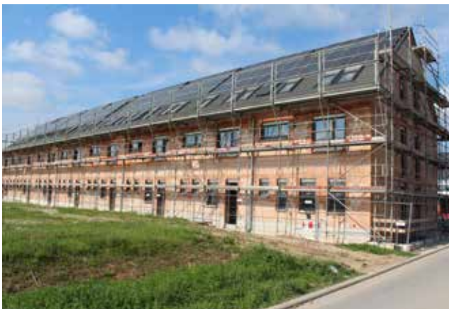
Abbildung 16: Rohbau der Herzo Base Energiespeicherhäuser aus Poroton-Ziegeln mit CALOSTAT-Füllung
