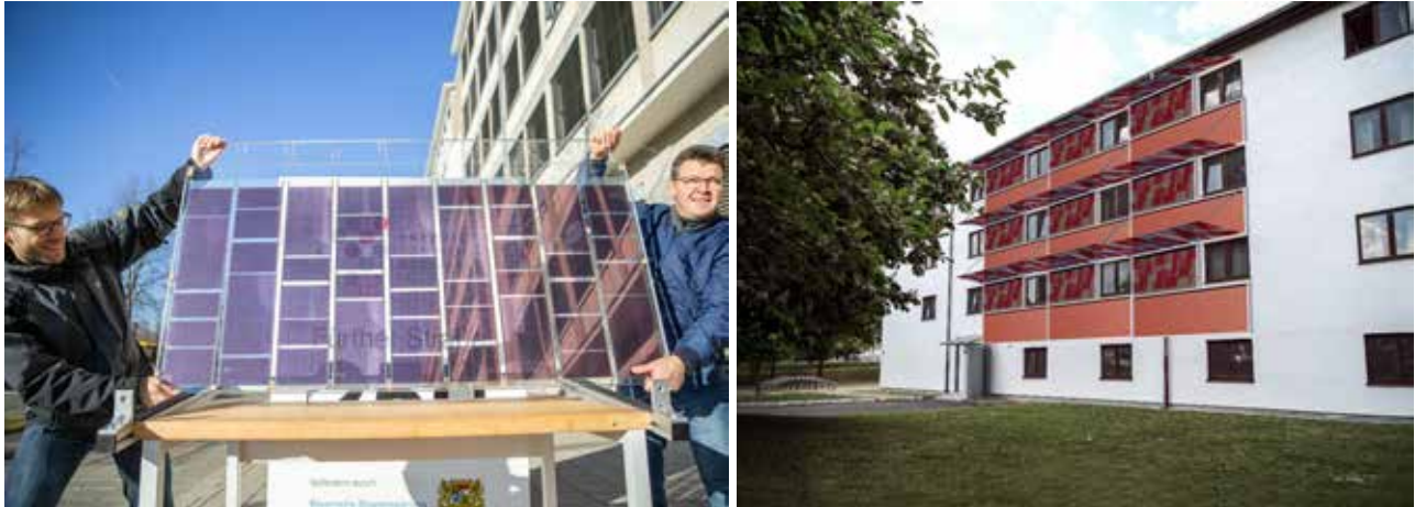
Abbildung 12: Links: Glasvordach mit einlamierten semitransparenten OPV-Modulen. Rechts: Computervisualisierung der Ansicht der Fassade des Demonstrationsgebäudes im Innopark Kitzingen mit den modularen multifunktionalen Fassadenelementen, incl. OPV-Glasvordächern.
