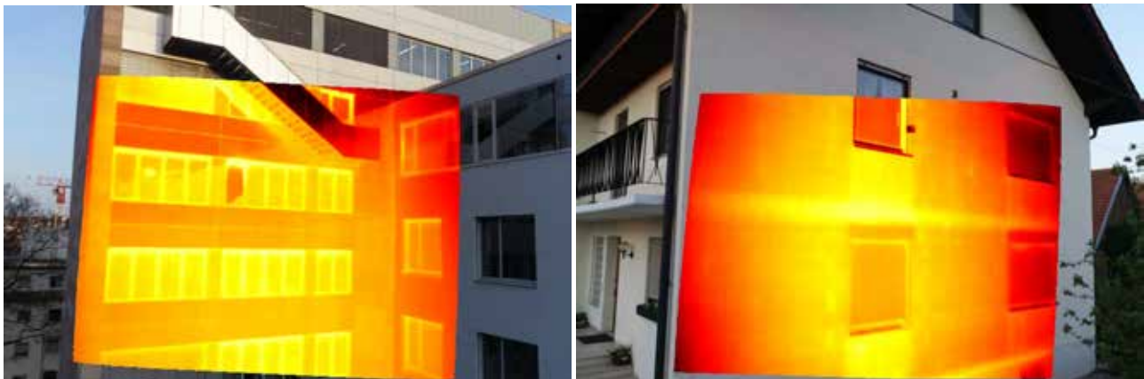
Abbildung 23: Drohnenaufnahmen von Gebäuden mit optischer Kamera und korrekt registrierten Thermografie-Aufnahmen.
