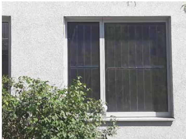
*Abbildung 1.24: Außenansicht des mit OPV bestückten Fensters und des durch die Fensterlaibung und -sturz hervorgerufenen Schattenwurfes.*
