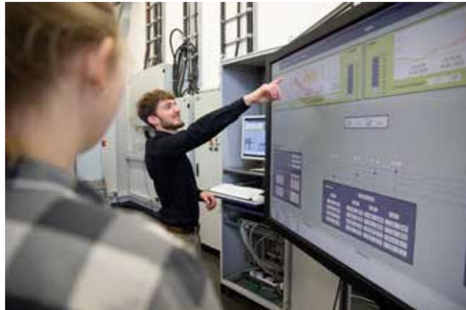
*Abbildung 2: Das Mikronetz ENGiNe am EnCN wird über einen zentralen Microgrid-Controller geregelt*
