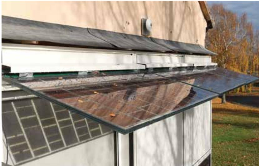
Abbildung 72 "Mockup" der für das Boardinghouse des INNOPARK Kitzingen geplanten multifunktionalen Fassade mit den drei semitransparenten OPV-Glasvordächern der "Solarfabrik der Zukunft". Die Glasvordächer fungieren sowohl als Sonnenschutz als auch als Stromversorgung.
