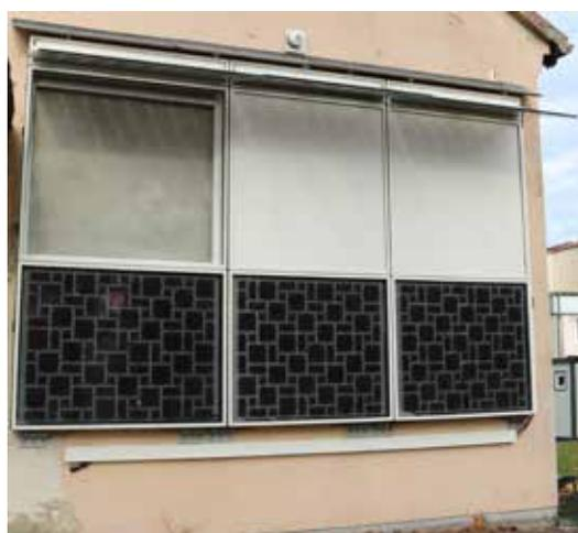
Abbildung 1.26: Fassaden-Mock-up mit integrierter Messtechnik, Standort INNOPARK Kitzingen.
