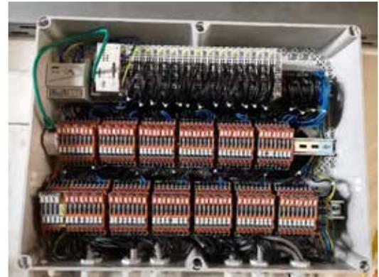
Abbildung 1.30: Konzept für die Kommunikationsinfrastruktur (links). Nachgerüstete Messtechnik, als Schaltschrankmodule in hoher Montagedichte mit digitaler Anbindung, WAGO Systembus mit zentralem Controller (rechts).
