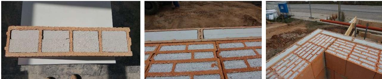
Abb. 15: CALOSTAT-gefüllter WDF 12 Ausgleichsziegel (Links). Zweischalige Bauweise mit 30 cm dicken perlit-gefüllten Mauerziegeln und 12 cm dicken CALOSTAT-gefüllten WDF 12 Vorsatzziegeln (Mitte). Zweischalige Bauweise im Eckbereich des Erdgeschoss (Rechts).
