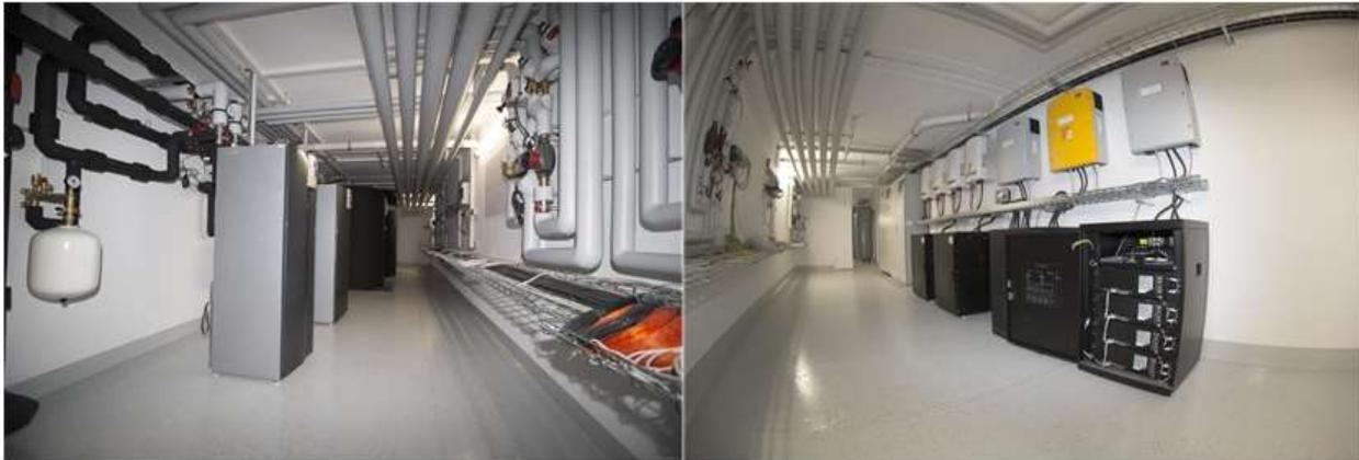
Abb. 14: Technikraum mit Wärmepumpen und Batterie (Stand: Dezember 2017)
