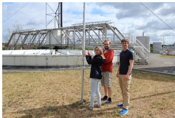
Betrieb der 10 kW Klein-Windanlage
