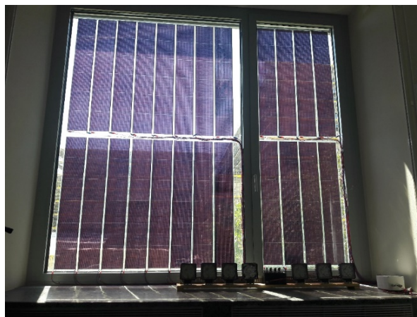
Abbildung: Versuchsstand mit Solarmodulen
