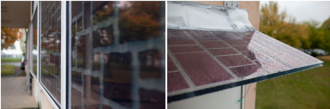
Abbildung: Testfassade in Kitzingen
