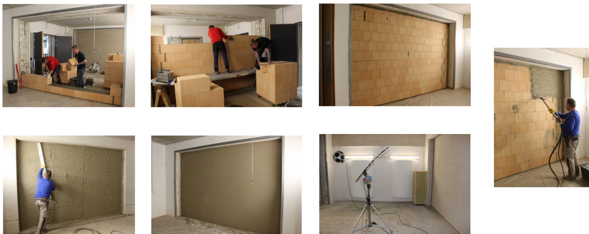
Abbildung 8: Aufmauerung einer Versuchswand aus neu entwickelten Zonen-Ziegeln in den Schallschutz-Prüfstand und Applikation von Innen- und Außenputz. Nach einer Aushärtezeit von 10 Tagen erfolgte die Messung der Schallabsorption.
