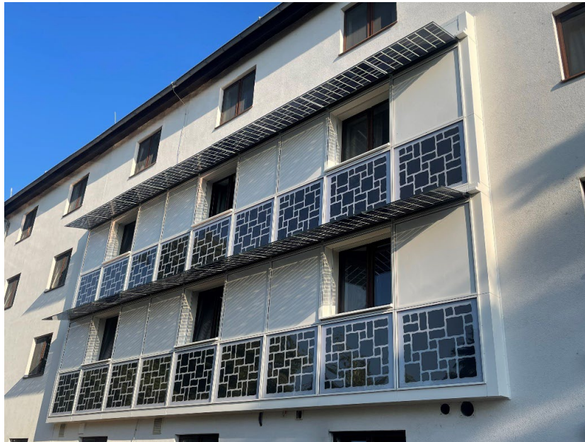
Abbildung 13: Demonstrationsfassade mit integrierter organischer Photovoltaik.
