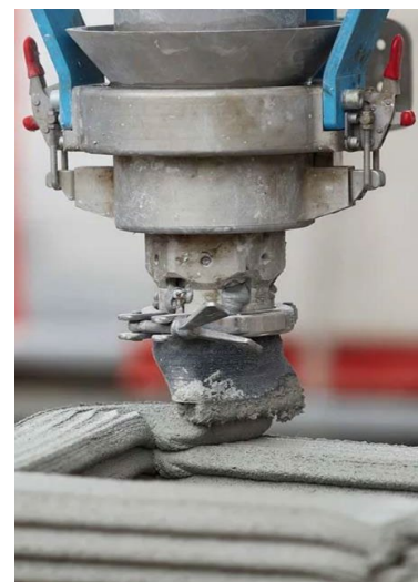
Eingesetzter Sekundärrohstoff (Recycling-Bauschutt) (links) für den 3D-Druck von Gebäuden im Layer-Verfahren (rechts)
