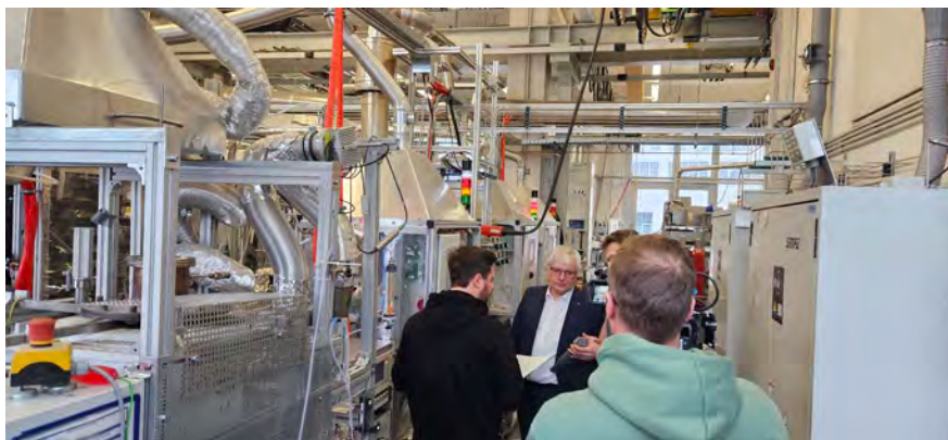
Labor mit Methanisierungs- und Verbrennungsanlagen
