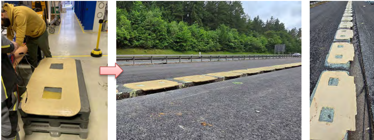
Abbildung 1: Von dem Labor auf die Straße. Spulen werden im Labor getestet und in dem Pilotprojekt in die Autobahn eingebaut. Quelle: Seamless Energy, Jakob Schmitz
