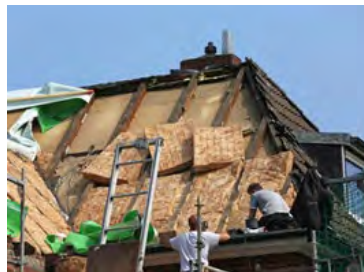
Abbildung 65: Dachsanierung eines Altbaus mit Zwischen- und Aufsparrendämmung [8]
