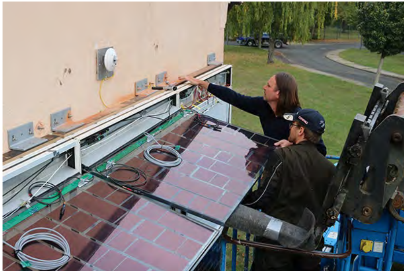
Abbildung 41: Montage des horizontalen sommerlichen Wärmeschutzes am Mock-up mit Blick auf die Anordnungsstrategie der organischen Photovoltaik
