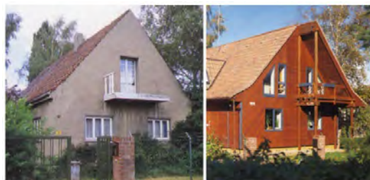
Abbildung 62: Wohnhaus vor und nach der Sanierung mit hinterlüfteter Vorhangfassade aus Holz [5]
