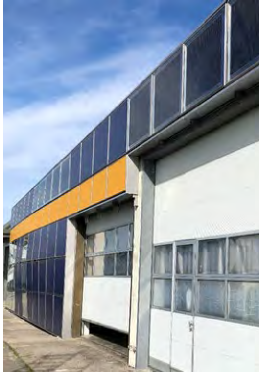
Abbildung 37: Ansicht der fertig eingehängten Elementfassade am Versuchsgebäude, farblich voneinander unterscheidbar sind die unterschiedlichen Materialien – die Elemente mit integrierter Photovoltaik befinden sich in der obersten Reihe.
