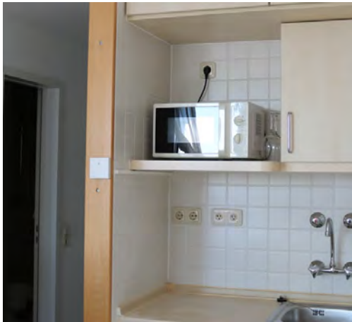
Abbildung 43: Raumsensor (montiert an der Holzleiste)
