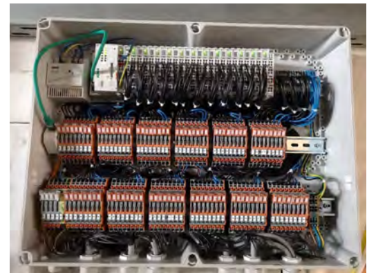
Abbildung 51: Konzept für die Kommunikationsinfrastruktur (links). Nachgerüstete Messtechnik, als Schaltschrankmodule in hoher Montagedichte mit digitaler Anbindung, WAGO Systembus mit zentralem Controller (rechts).
