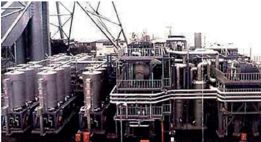
**Abb. 64:** Bisher größte realisiertes PAFC-basiertes Kraftwerk in der Nähe von Tokio (11 MW<sub>el</sub>), nicht mehr in Betrieb.<sup>122</sup>
