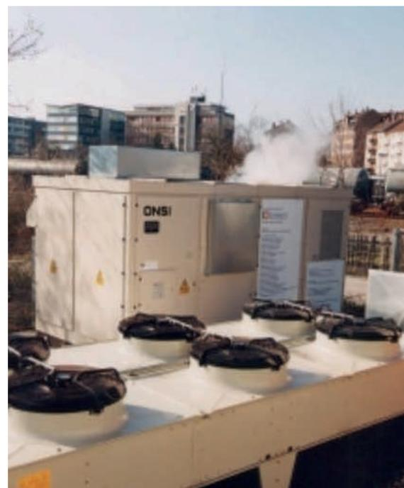
**Abb. 63:** 200 kW Onsi-PAFC Brennstoffzelle (PC25C) der EWAG AG in Nürnberg, 1998
