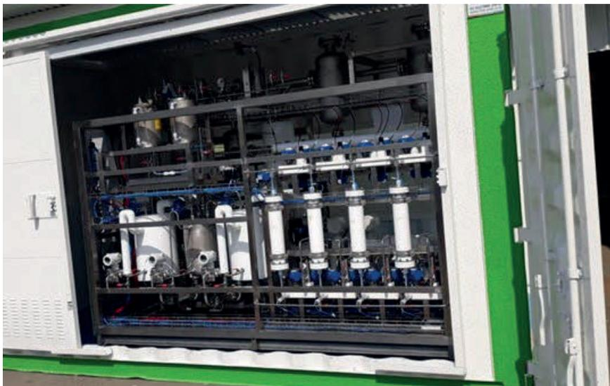
**Abb. 9:** Demonstrationsanlage der E-TAC Wasserspaltung basierend auf membranfreier Alkalischer Elektrolyse des Start-Ups H2PRO, Gewinner der Shell Energy Challenge 2020.<sup>14</sup>
