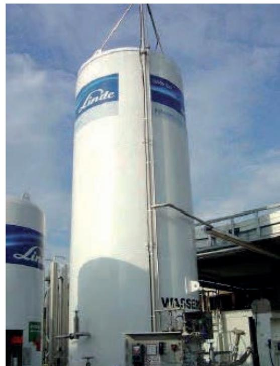
**Abb. 39:** Wasserstoffkryospeicher der Firma Linde
