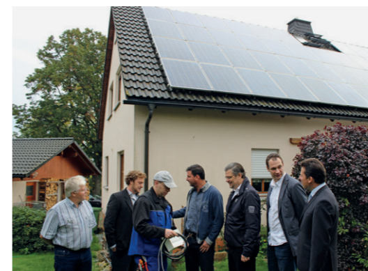
Installation spezieller Zählerhardware für eine lückenlose Erfassung des Netzzustands in Epplas
